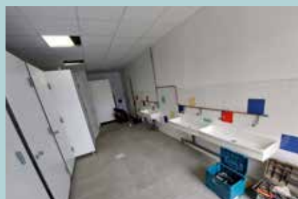
Création de nouveaux sanitaires à l'école Jules Ferry
