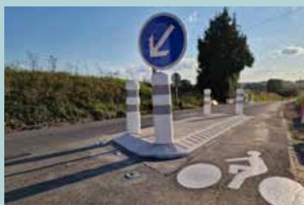
Création d'une entrée écluse, route de Millencourt
