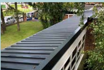
Rénovation de toitures et des coursives des écoles Daudet
