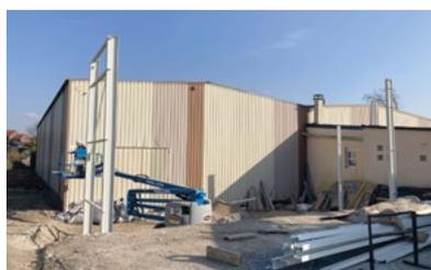
Montage de la charpente métallique pour le terrain de Padel au Tennis Stade d'Albert.
