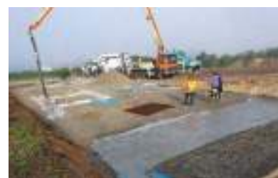
Terrain multisport - Début des travaux de terrassement
