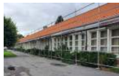
École Jules Ferry - Réfection complète de la toiture
