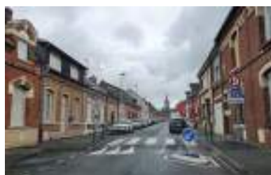
Rue Jean Jaurès - Réalisation de 3 écluses et création de 13 places de stationnement
