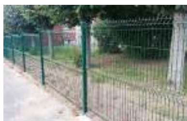
Gymnase Paul Langevin - Réalisation d'une clôture d'enceinte
