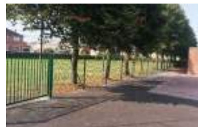
École Alphonse Daudet - Pose d'une clôture sécurisée et réalisation d'enrobés
