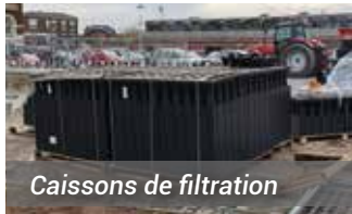
Des bassins de 250 m² au sol ont été creusés pour la filtration des eaux pluviales
