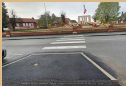
Sécurisation de la traversée piétonne face au monument aux morts
