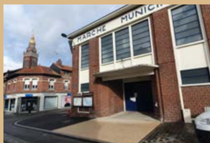
Modernisation de l'entrée du marché couvert
