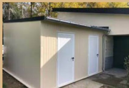
Construction d'une extension des vestiaires au stade du Vélodrome
