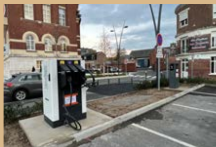
Installation de cinq bornes de recharge électriques sur le parking du TJP
