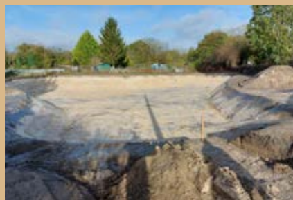
Réfection rue d'Ovillers avec création d'un bassin d'infiltration des eaux pluviales
